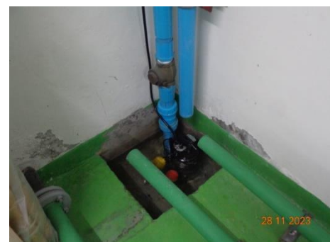
ภาพที่ 2.2-24 เครื่องสูบน้ำบริเวณบ่อหมุนน้ำ
