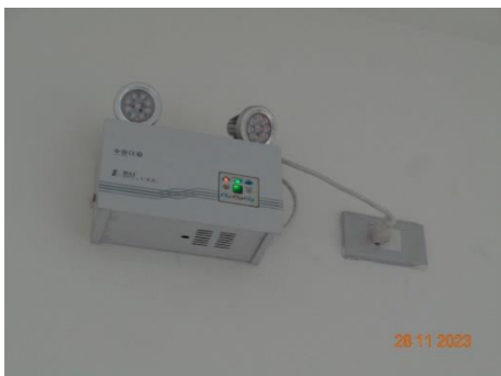
ภาพที่ 2.2-35 ระบบไฟส่องสว่างฉุกเฉิน
